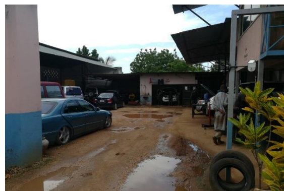
Bei Regen steht der Innenhof schnell unter Wasser.
